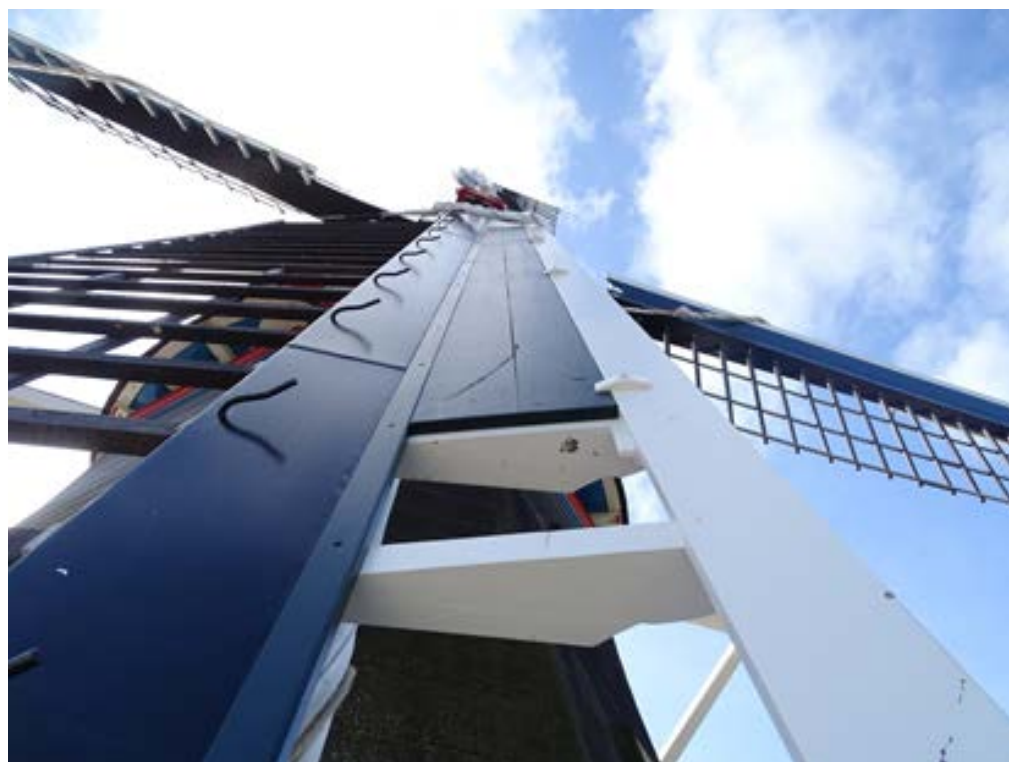
Buitenschilderwerk met een dampopen systeemverf
