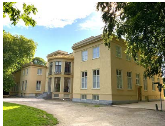
Raadhuis 'De Paauw' Wassenaar voor en na het aanbrengen van historisch schilderwerk op houten ondergronden waarbij de bestaande alkydhars verf is vervangen door een traditionele lijnolieverf uitgevoerd in historische kleurstelling.
