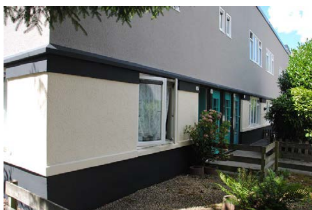
Buitenschilderwerk op beton.
