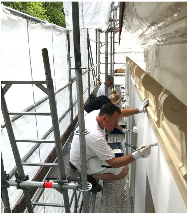
Voor historisch buitenschilderwerk gelden extra eisen vanwege het respecteren van verfsystemen uit het verleden.
