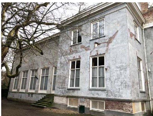
Raadhuis 'De Paauw' Wassenaar voor en na het aanbrengen van historisch schilderwerk op houten ondergronden waarbij de bestaande alkydhars verf is vervangen door een traditionele lijnolieverf uitgevoerd in historische kleurstelling.
