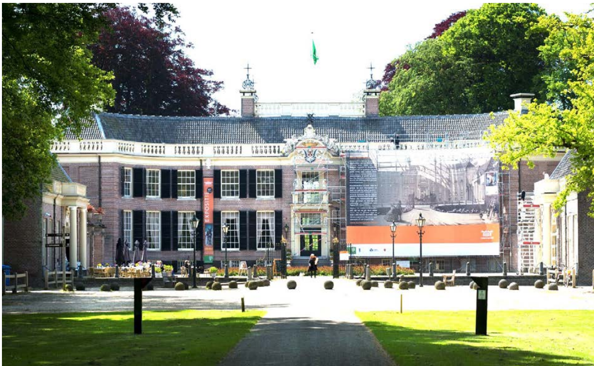
Onderhoud en restauratie van schilderwerk aan monumenten.
