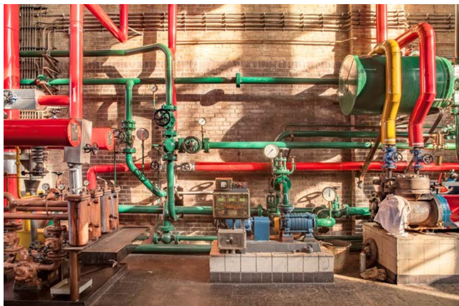
Historisch binnenschilderwerk op staal in de stookruimte in het Woudagemaal in Lemmer.
