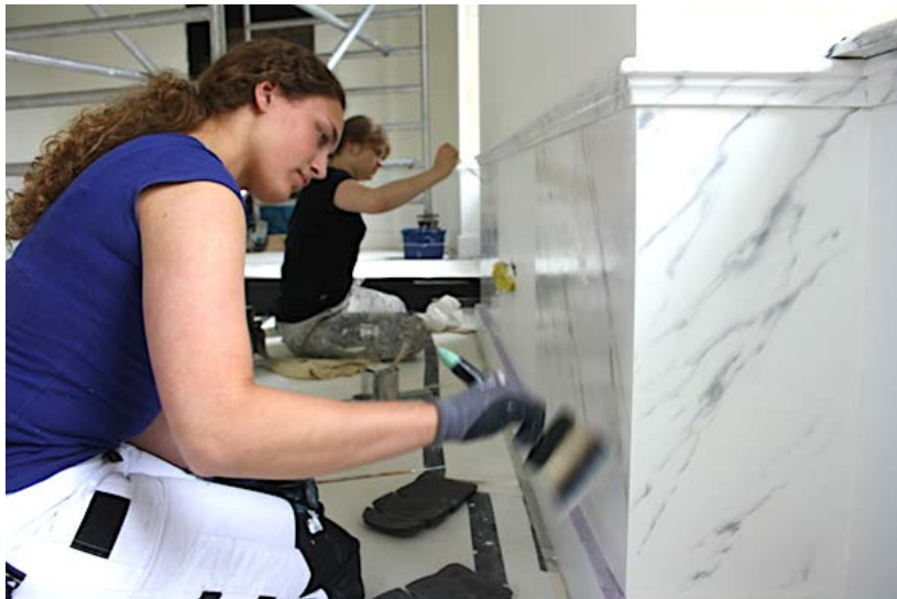
Het aanbrengen van een imitatie van witmarmer.
