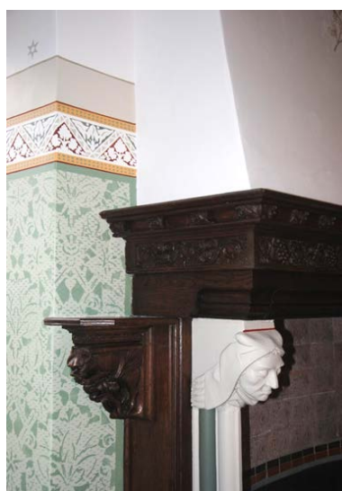
Binnenschilderwerk op steen afgewerkt met decoratief sjabloneerwerk.
