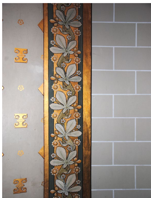
Bieswerk (rechts op de afbeelding) in kasteel 'de Haar', Haarzuilens
