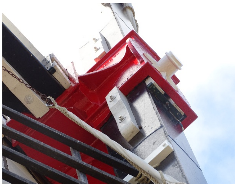
Buitschilderwerk op metalen ondergronden zoals hier de askop
