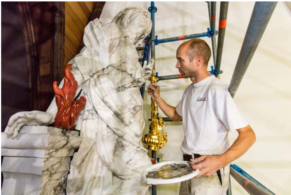
Bij de restauratie van het orgel in de Oude Kerk te Amsterdam werden verschillende bijzondere schildertechnieken toegepast: houtimitatie (par.3.8.1), marmerimitatie (par. 3.8.2) en verguldwerk (par. 3.8.9).
