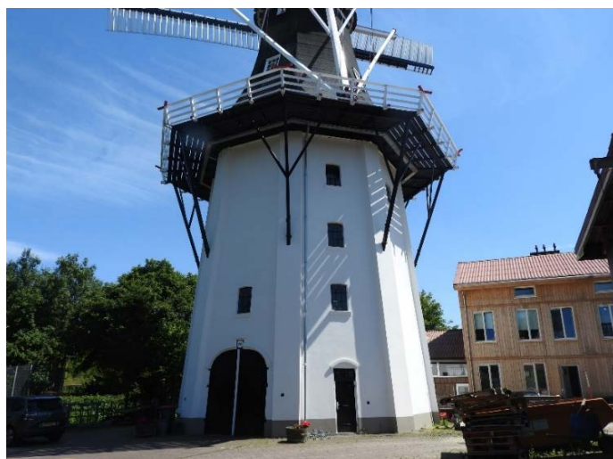
Buitenschilderwerk op een gepleisterde steenachtige ondergrond
