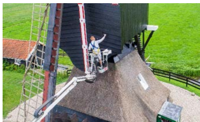
Reconstructie van oorspronkelijke koolteerlagen met teer vervangende producten
