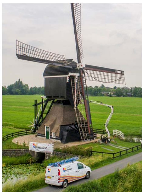
Personeel moet opgeleid zijn in het veilig werken met klimmateriaal, steigers en/of hoogwerkers
