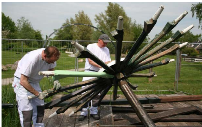
Onderhoudsschilderwerk aan de kruillier
